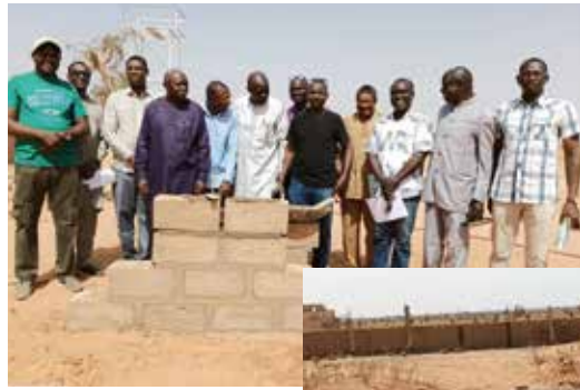
Feierlicher Baustart – gemeinsam werden die ersten Ziegel gesetzt
