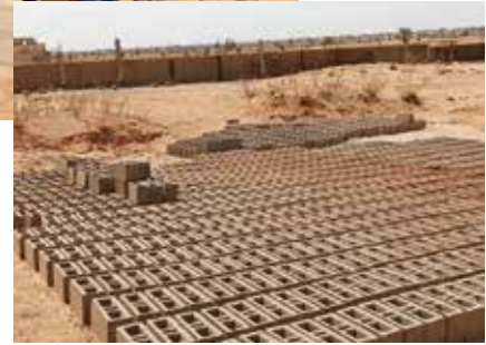
Die Ziegel werden vor Ort gebrannt
