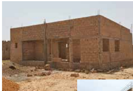
Seminar- und Bürogebäude noch ohne Dach und Fenster
